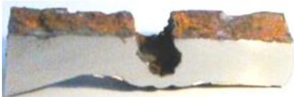
图1 焊接接头局部腐蚀
